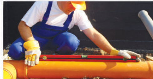
PIPE & GEN FITTER
